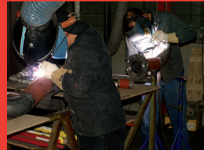
Laswerk: vervaardiging van metalen leidingsystemen in atelier alsook op werven Travaux de soudure: Fabrication de systèmes de tuyauterie en métal à l'atelier et sur chantier
