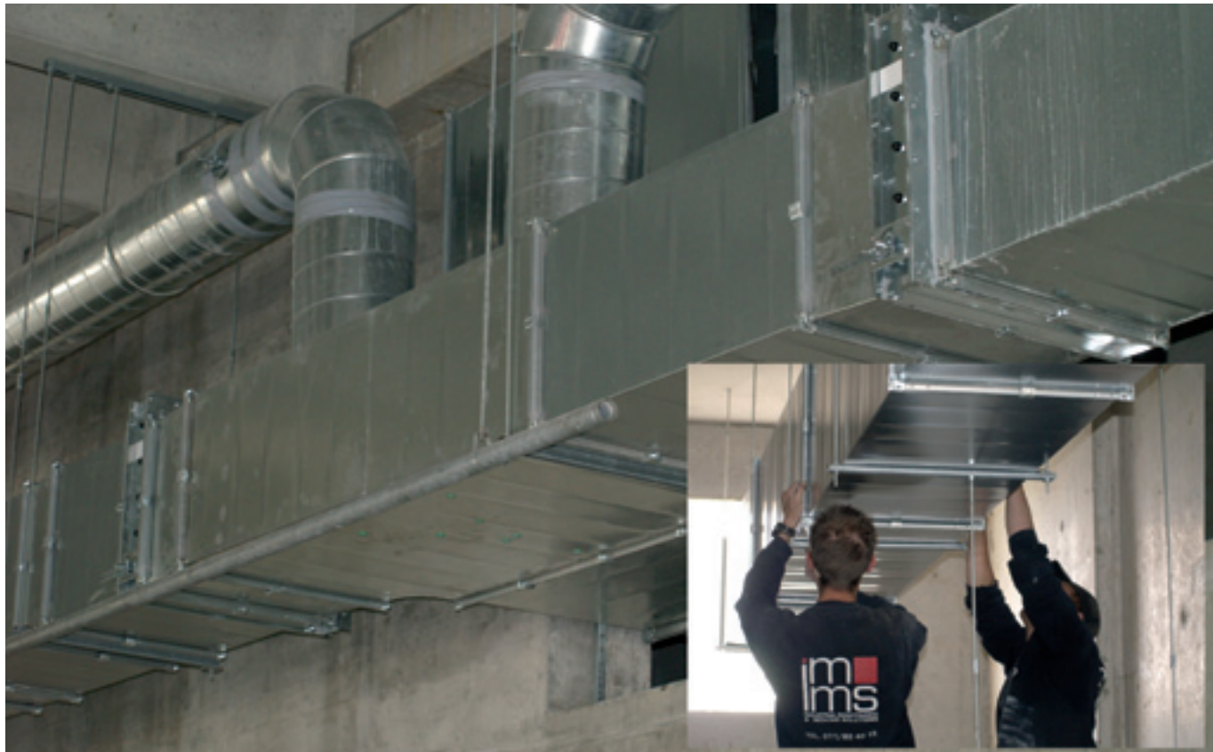
Maatwerk: Collector Travaux sur mesure: Collecteur
